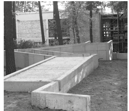
Betonfundament für die Rampe
